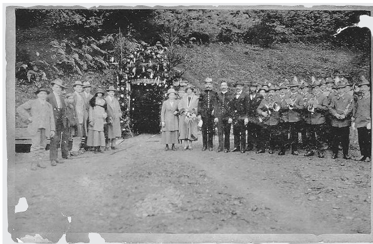
Einweihung des Eduard-Stollens in Vandans-Gadengla 1924
